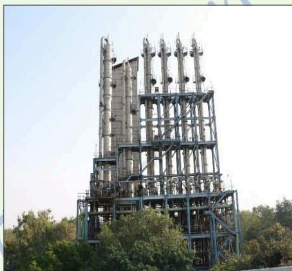
ड्यूटेरियम अवक्षयित जल उत्पादन के लिये आसवन कॅलम Distillation columns for production of DDW
